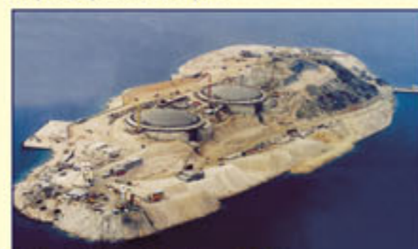
Δεξαμενές Φυσικού Αερίου - Ρεβυθούσα
